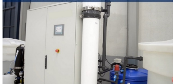
Traitement par filtration en profondeur et désinfection à travers des membranes d'Ultrafiltration.
