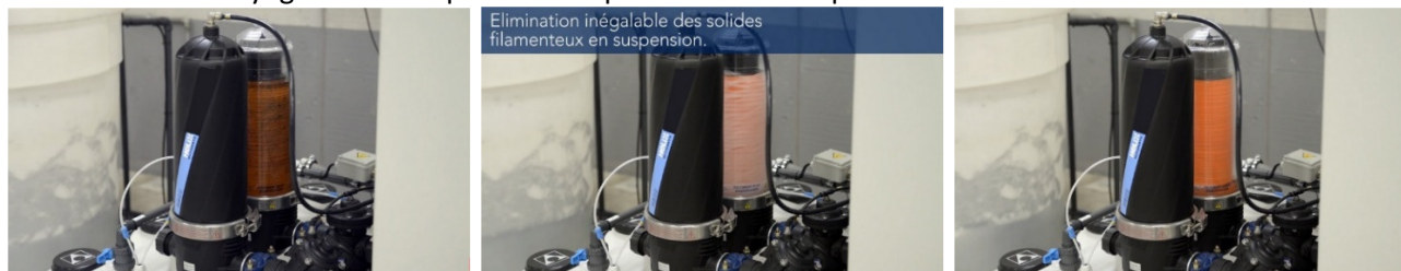
Traitement par filtration en profondeur et désinfection à travers des membranes d'Ultrafiltration.
